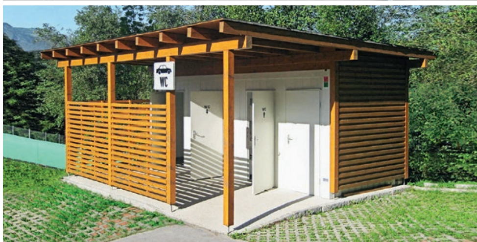
Prefabbricato modulare ad uso WC da 20' adattato come toilette per parcheggio
